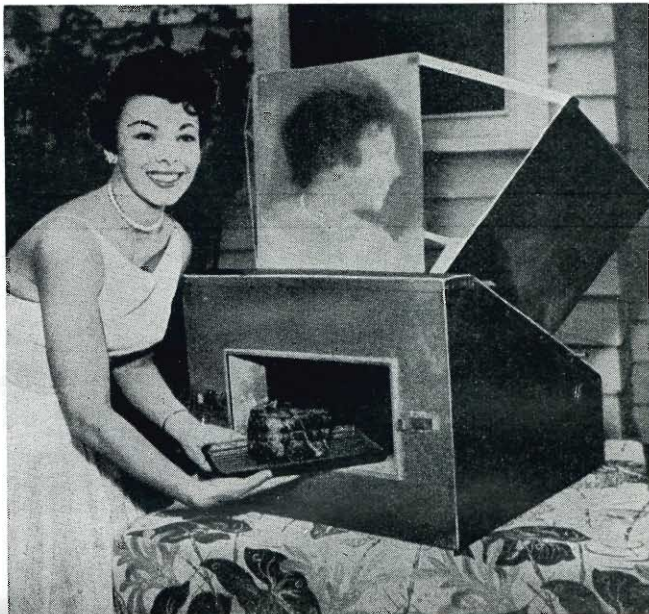
Un forno solare portatile costruito in alluminio è stato esposto a Disneyland. In questo modello, i raggi sono riflessi e concentrati nell'interno
