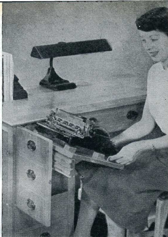
La macchina per scrivere e la macchina per cucire rimangono sospese nei loro scomparti. Per metterle in posizione di lavoro, si fanno scivolare nel binario dello sportello e poi si solleva la mensola
