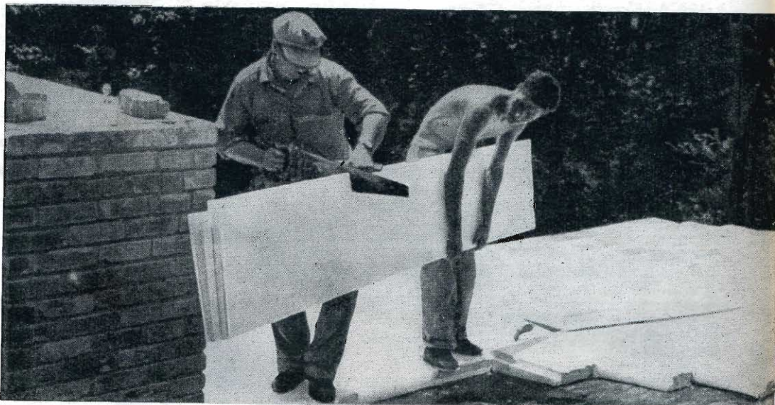
Le grandi assi per la copertura del tetto sono molto maneggevoli, e si possono segare o tagliare col coltello
